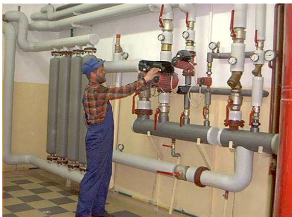
Zdj. 4. Wymienniki JAD 6/50 z zespołem pomp
