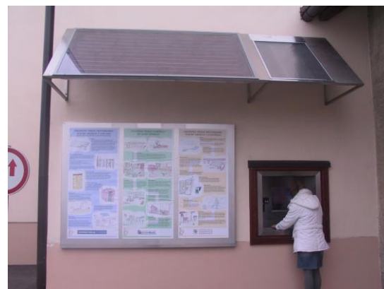
Kolektor słoneczny do ogrzewania wody i powietrza oraz punkt informacyjny
