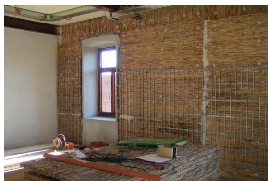
Płyty trzciniowe przykryte ścienną instalacją grzewczą
